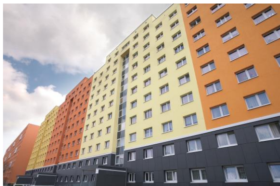
Панельный дом после санации (г. Лейпциг)
